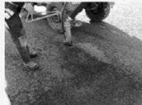
3. Schlaglochausfüllung mit bituminierten Splitt
